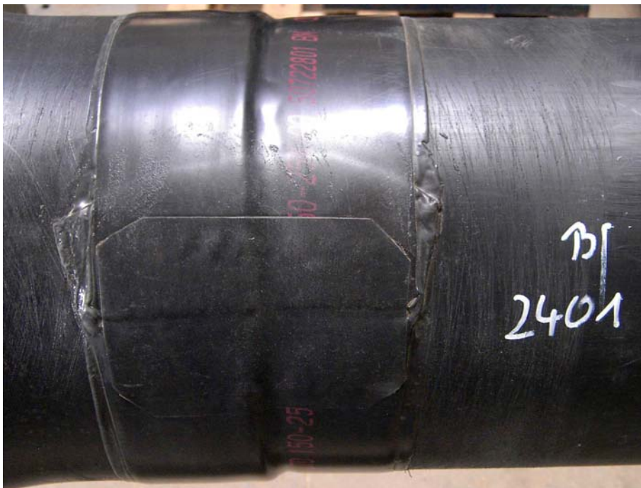
Bild 11: Muffenbereich „B“ von KMR 2401 in 12-Uhrlage vor der Prüfung
