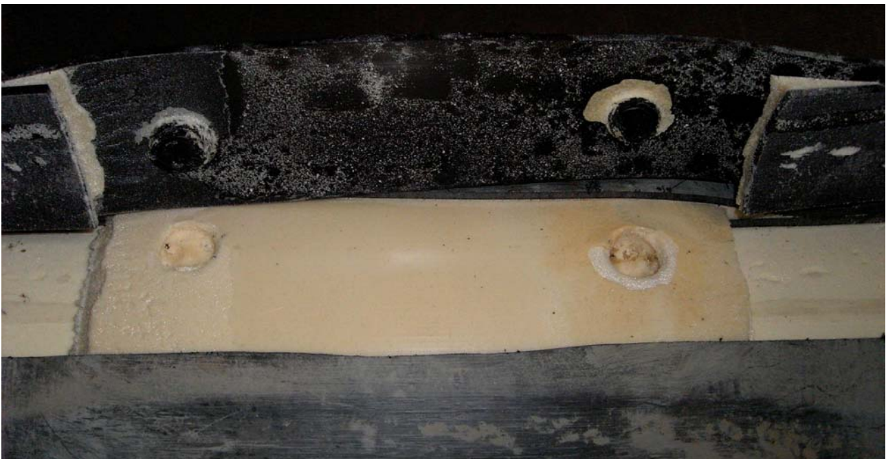
Bild 14: KMR 2401 nach Wasserundurchlässigkeitsprüfung: Die Muffe ist dicht.
