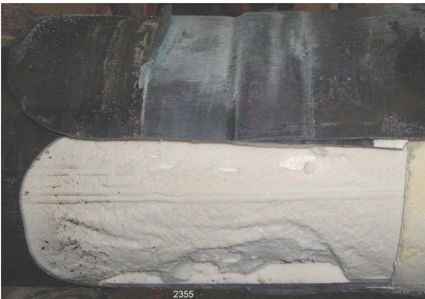
Bild 9: KMR nach Wasserundurchlässigkeitsprüfung: Die Muffe ist dicht.
